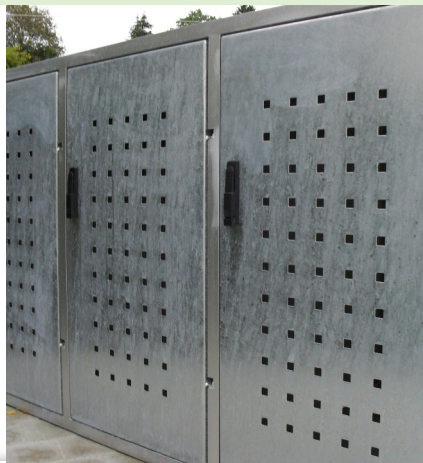
Nach kurzer Zeit und vor allem bei feuchter Witterung bildet sich der sog. Weissrost. Es können Schlieren und unterschiedliche Flecken entstehen.
